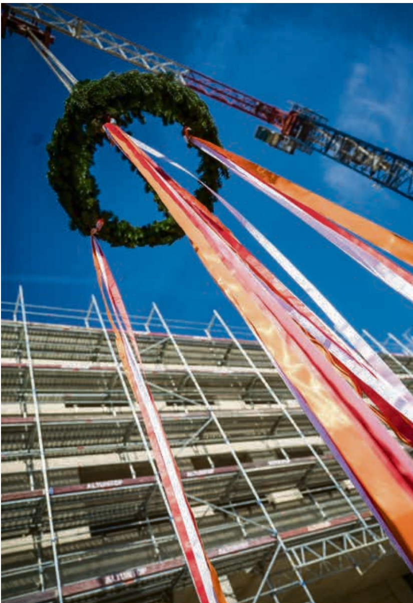
Großer Baufortschritt am Seltersberg: Die Richtkrone mit den bunten Bändern hängt weithin sichtbar am Rohbau des Instituts für Lungengesundheit (ILH).
