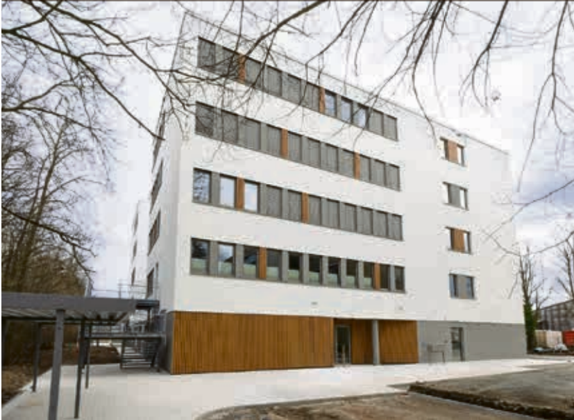
Der Neubau in der Rathenaustraße 10 beherbergt das ZfbK, das ZfL, die Servicestelle Hochschuldidaktik, das Akademische Prüfungsamt Geisteswissenschaften und das Institut für Philosophie.
