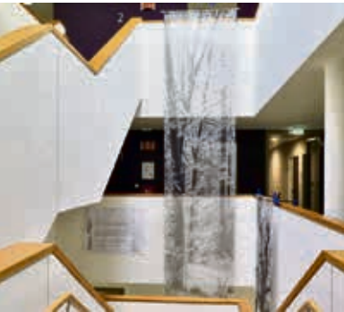
Ansichten vom Treppenhaus auf der mittleren Ebene im GCSC-Gebäude.
